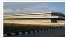
AJIYA SAFETY GLASS SDN. BHD. Bukit Minyak, Pulau Pinang
